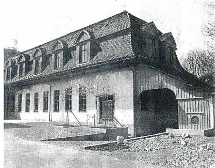
Der Kuppelbau der Fabrik am Rotbach (ehemals die alte Bleicherei) von 1916 mit den fünf durch einen Abbruch wieder freigelegten hinteren Fenstern. (Bilder: pd.)
